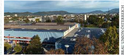
Die Photovoltaikanlage der Brauerei Puntigam mit Blick auf das Brauquartier Puntigam.
